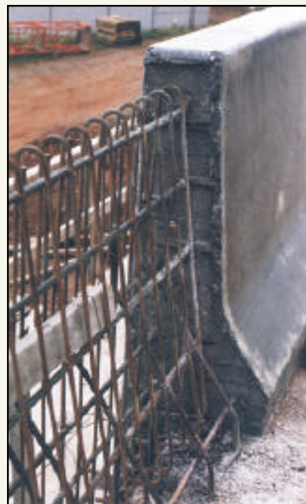
Chaque côté du Pont de la Confédération, le parapet de 1,1m de haut est construit en béton haute résistance renforcé de treillis structuraux soudés 11,3mm / 16,0mm.
